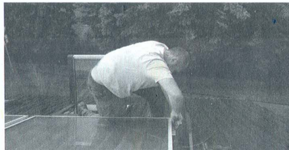
POKLÁDÁNÍ solárních panelů na novou střechu budoucího stacionáře ve Velké Chmelištné. Foto: archiv Andromédy
