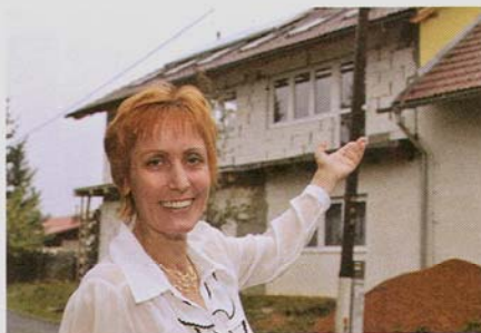
„Na projektu hospice pracujeme již deset let ve svém volném čase po zaměstnání. Sháníme peníze, kde se dá, a tak jsme Fondu Zelené energie vděční za podporu našeho projektu. Navíc solární panely nám na energiích ušetří mnoho peněz i v budoucnu,“ říká předseda občanského sdružení Společenství Androméda, Lenka Petříčková.
